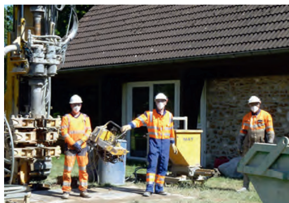
Figure 2 - Un ingénieur (au centre) et deux géotechniciens lors d'un forage pour de la géothermie très basse température © I. VELTZ.
